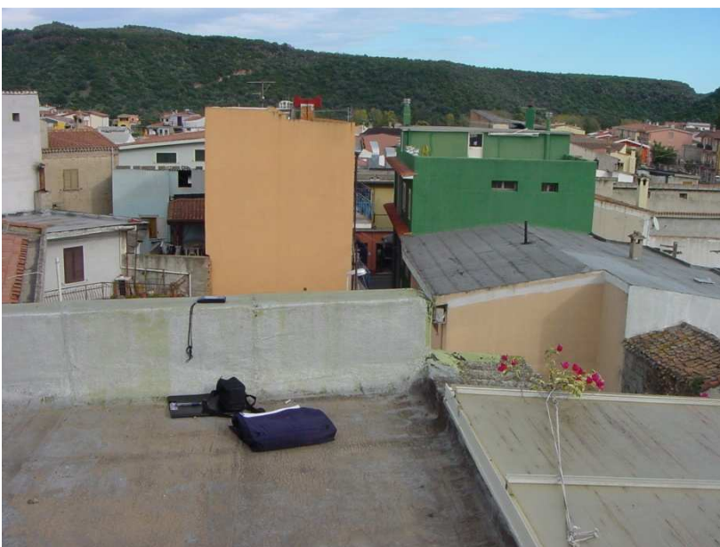
Figura A6b: porzione dei lati NE e SE del tetto sul quale dovrà essere installata la stazione climatologica di Barisardo.
