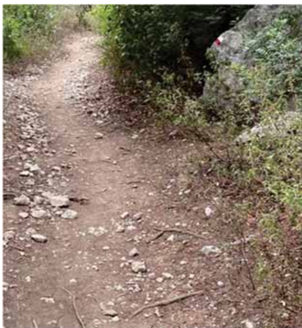
Parte iniziale del sentiero con spietramento, pulizia fronde e segnaletica orizzontale sulla roccia
