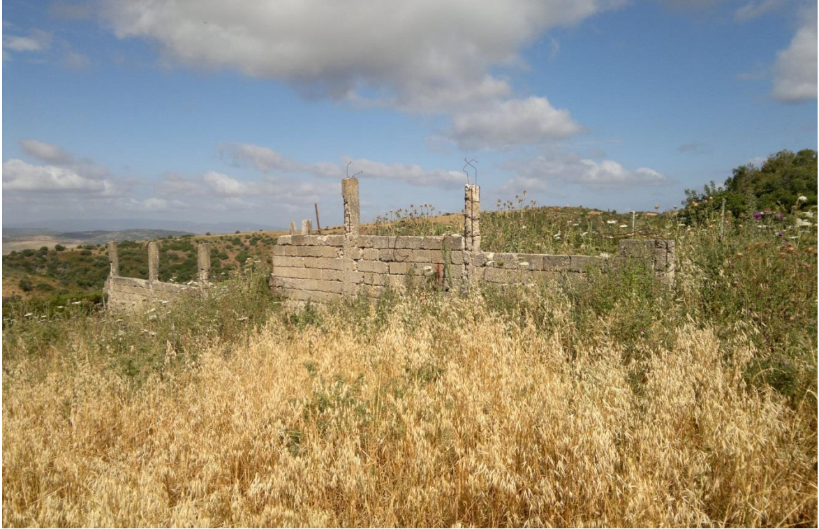
Figura 6- Parte delle murature e piastri ancora in piedi.
