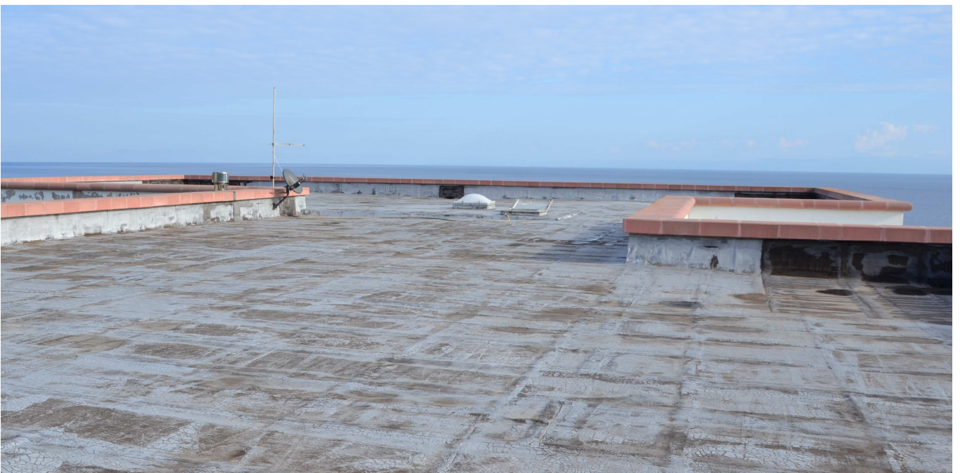
Vista generale della copertura con le due botole d'accesso
